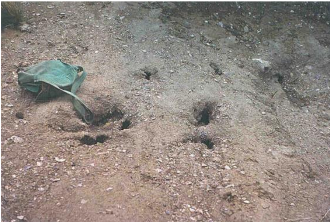
Foto 8: Piping en sus primeros estadios superficiales. Formación de hoyos por erosión subsuperficial.
