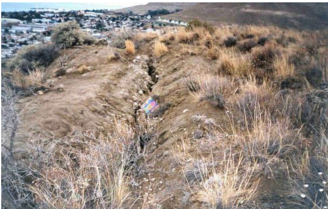
Foto7: Grieta en el material deslizado. Nótese la morfología de la grieta, que evidencia sucesivas aperturas y las líneas de drenaje hacia la misma. Cuaderno de escala.
