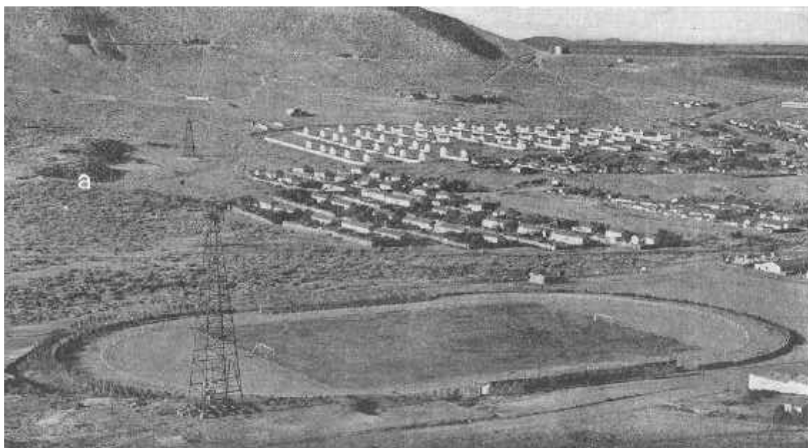
Foto 18: Foto tomada del BIP n°228 (1943). Se observa al oeste la manifestación de la cresta de presión (a).
