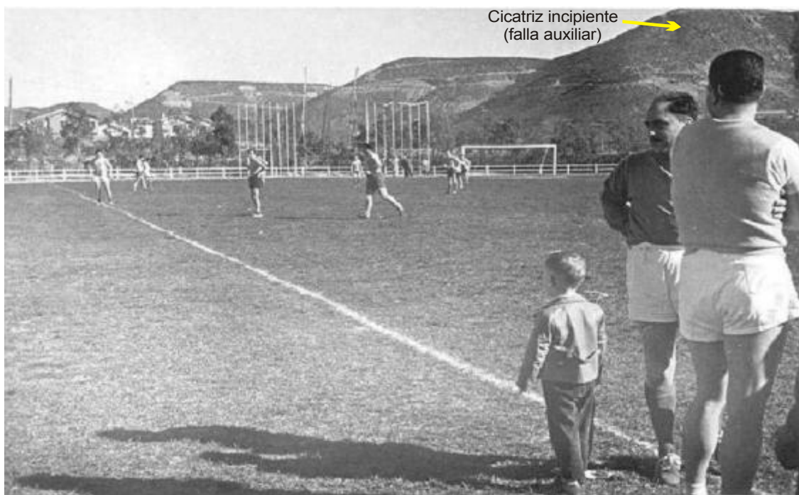
Foto 20: Foto cedida por el Sr. Marcelo Simeoni (año 1958). Se observa el sector A (ver Croquis, pag. 28) con la cicatriz abierta (proyección de la falla B o auxiliares), y ausencia de material movilizado sobre la ladera.
