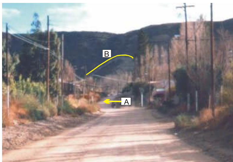
Foto 10: Escalón en la calle J. Aimar, que responde a la cresta de presión (A). Se señala también un deslizamiento rotacional en la parte posterior del Barrio (B)
