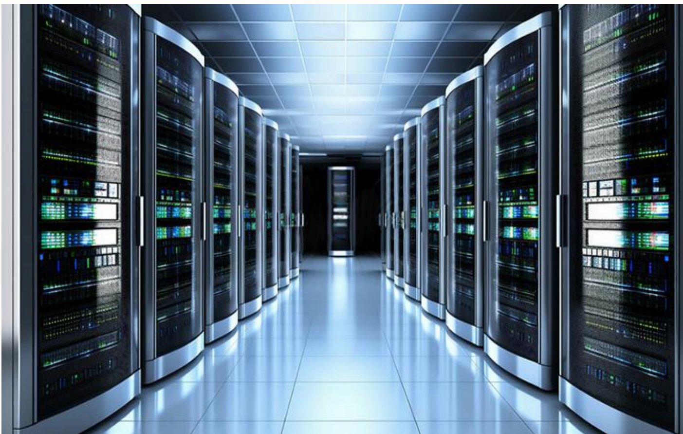
Data center de IA
